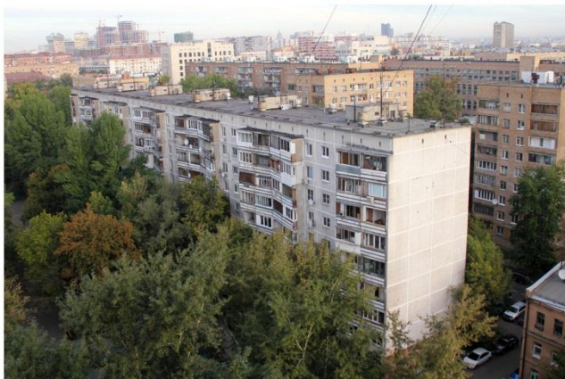
ПАНЕЛЬНЫЙ ЖИЛОЙ ДОМ СЕРИИ 1-515/9Ш
